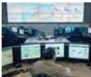
computadoras y equipos especializados conectados a sensores que hay por toda la tubería a fin de detectar cambios en la presión que puedan indicar un problema.
